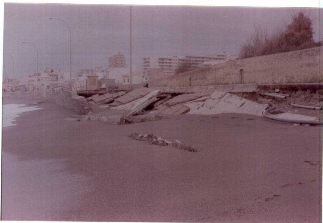
FOT. nº 11. Vista general del estado del paseo peatonal (Playa de la Carrihuela), al 19-3-83.
